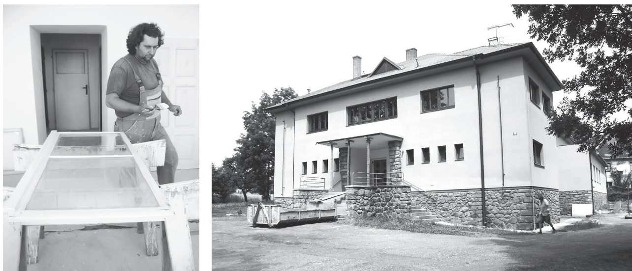
Nátěr oken ve výstavních prostorách zámku - lakýrník Procházka. Oprava exteriéru KD Slabce.
