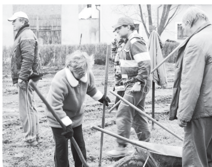
Budování hřiště v Rousínově. Foto: OSR
